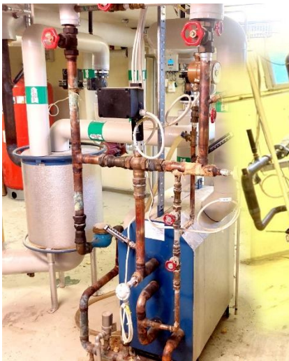
De grå "burkarna" är de gamla växlarna.
